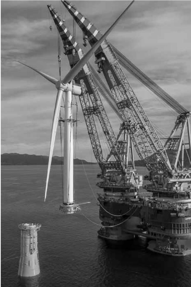
Figura 14, Installazione su una struttura galleggiante ancorata al fondo marino (a sinistra) di un turbo-generatore eolico, completamente assemblato, da 6 MW (appeso alla gru del pontone). Fonte figura SAIPEM <https://www.saipem.com/it/progetti/hywind>
