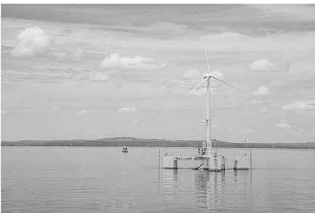
Figura 12 ter, Torre eolica offshore galleggiante tipo "zattera" (barge)
