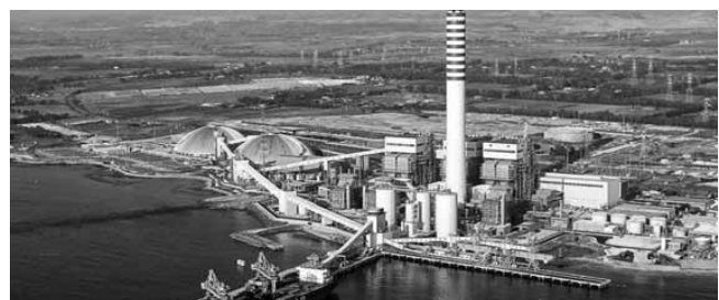
Figura 9, Centrale a carbone Torrevaldaliga Nord (USC 3 x 660 MW; 250 bar, 600°C SH / 610°C RH), a carbone bituminoso Sud Africano (S<1%), in servizio dal 2009 in località Torrevaldaliga, nel comune di Civitavecchia.
